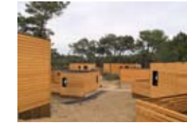
7- Módulos Belambra (Capbreton)
